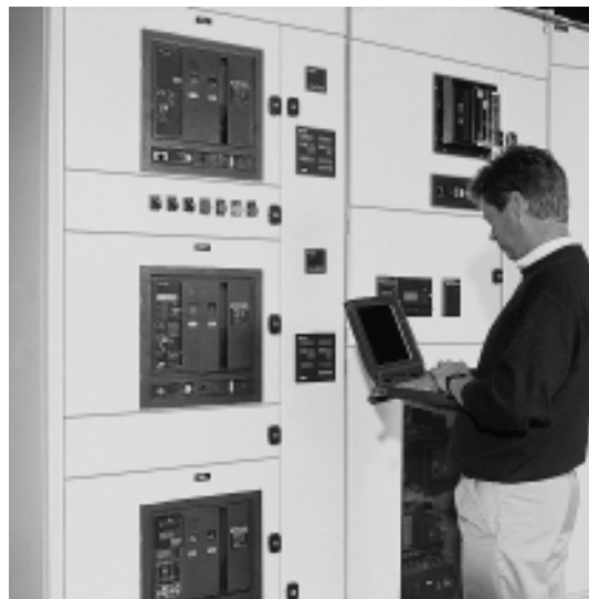
Fig. 1: Actualmente, la inteligencia está integrada en los cuadros BT (Digibloc - Merlin Gerin).
